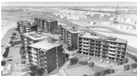
平成25年度完成予定の田子西復興公営住宅
